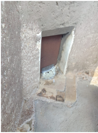
Fig. 3. Vano del foro stenopeico visto dall'esterno.
