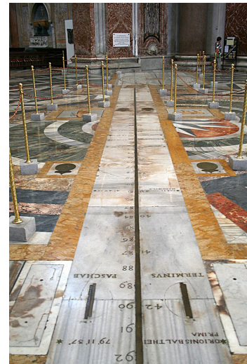
Fig. 2. Linea Clementina vista dall'Equinozio. Sono visibili la linea meridiana fatta di ottone, il marmo bianco di Carrara, il marmo giallo di Verona, le due scale graduate e la linea dell'Equinozio.
